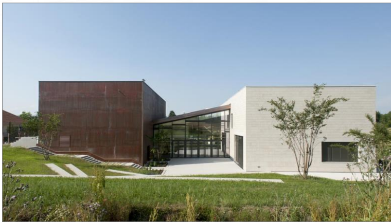
Credit photo : Béatrice CARRIER / De Jong architectes
